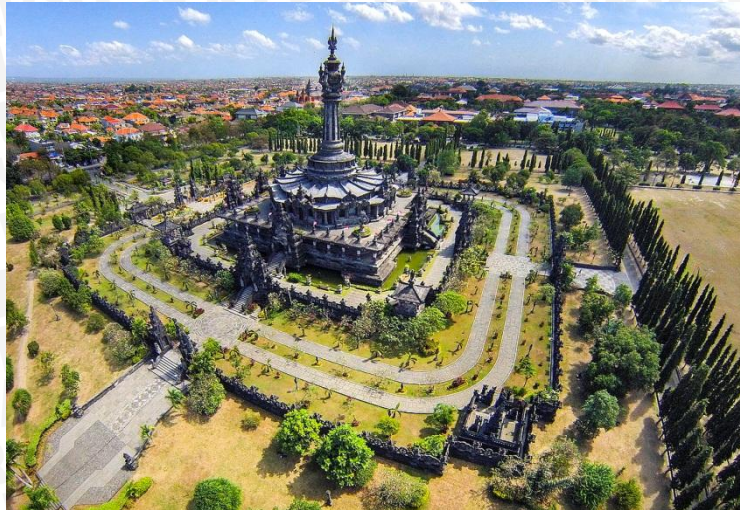
Gambar 4. 31 Bajra Sandhi, Renon, Denpasar, Bali dengan ketinggian 45 meter
