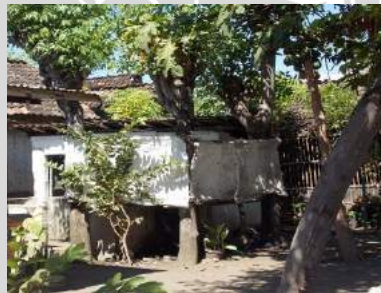
Gambar 4.42 : Kamar mandi di luar bangunan
