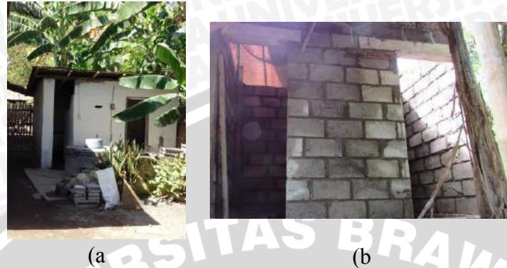
Gambar 4.288 : (a) kamar mandi area Selatan dan (b) kamar mandi area Utara
