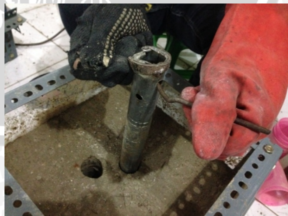
Pembuatan Kolom-Kolom DSM
