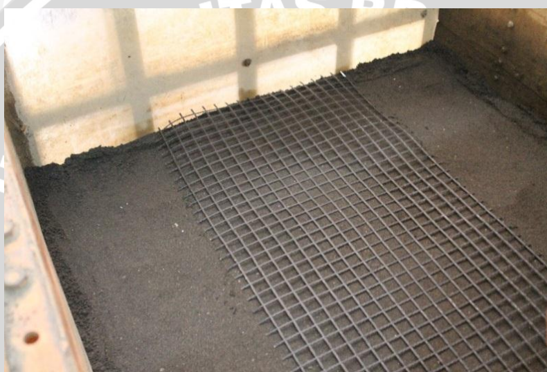
Peletakan geogrid diatas tanah pasir sesuai perencanaan
