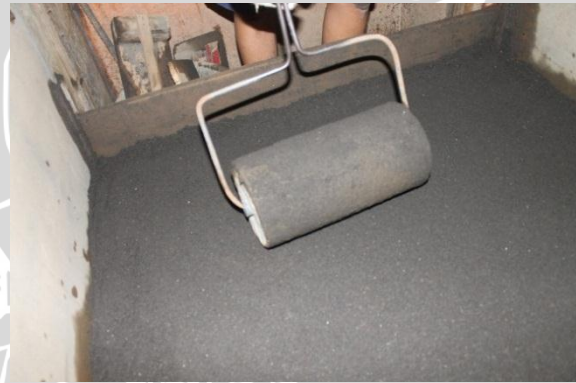
Proses pemadatan dengan silinder beton
