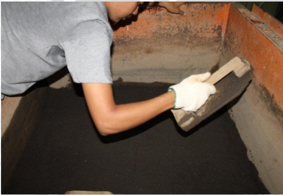
Proses pemadatan tanah pasir
