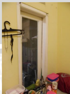
Gambar 4.15 Jendela utara pada Ruang II
