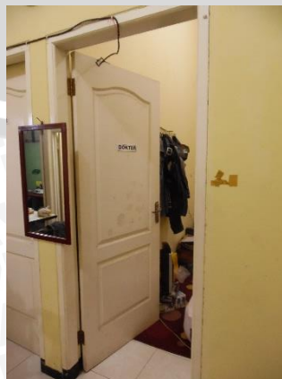
Gambar 4.10 Pintu pada Ruang I
