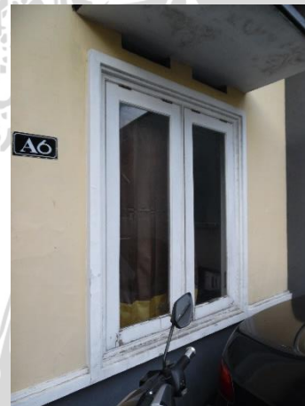
Gambar 4.9 Jendela pada Ruang I
