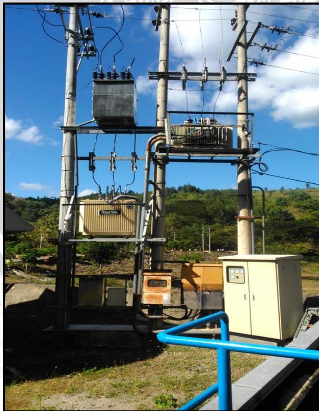
Gambar 3.5. Pemasangan Dua Tiang untuk Trafo
