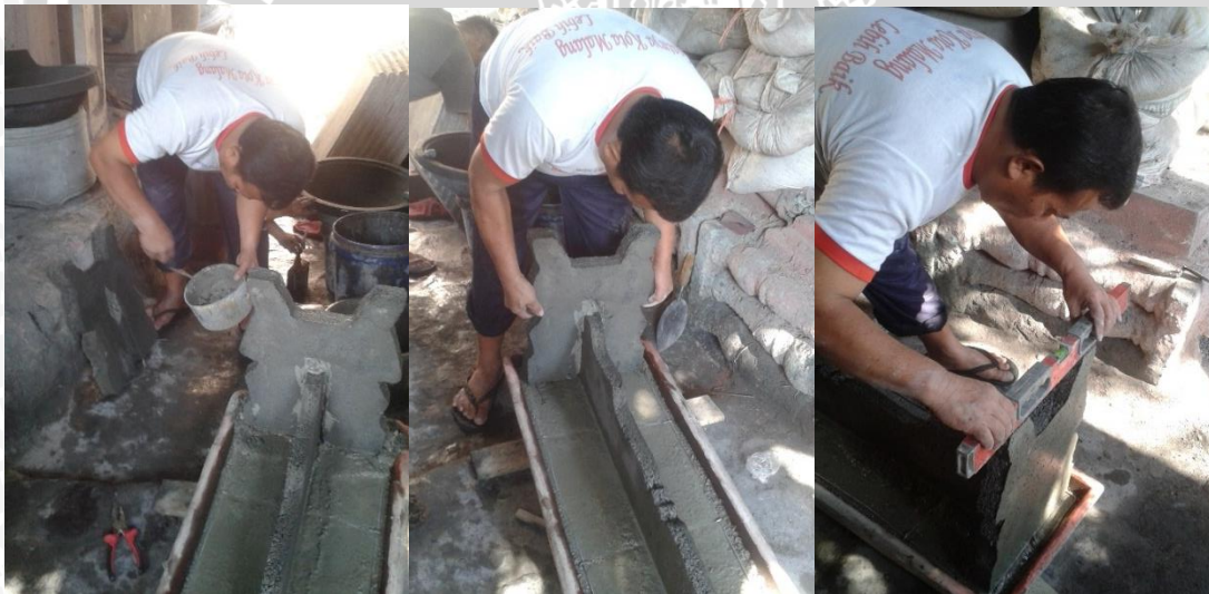
Gambar 4.26 Pemasangan kaki kursi teraso
