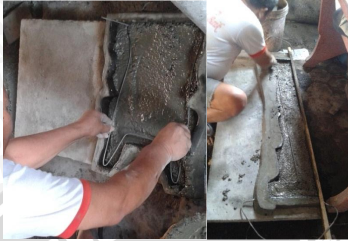
Gambar 4.17 Pemasangan kawat pada kaki dan penyangga kursi teraso
