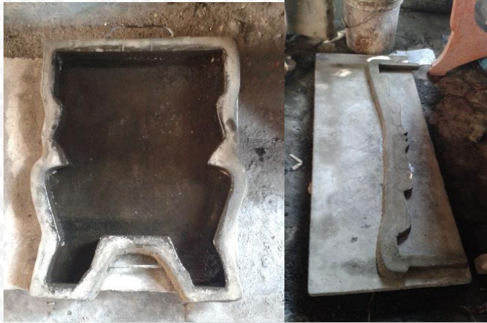
Gambar 4.14 Persiapan cetakan kaki dan penyangga kursi teraso
