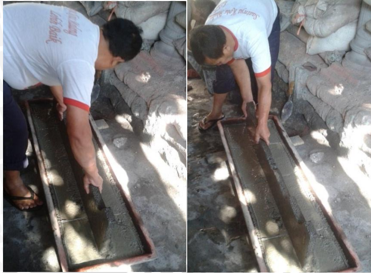
Gambar 4.25 Pemasangan penyangga kursi
