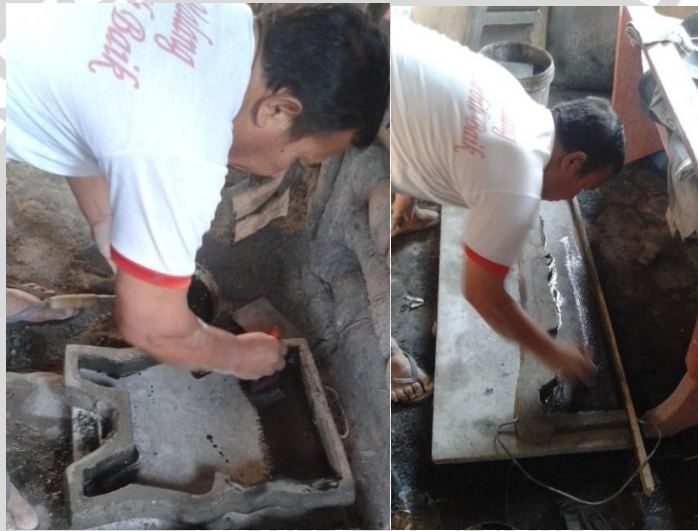
Gambar 4.15 Pelapisan oli pada cetakan kaki dan penyangga kursi teraso
