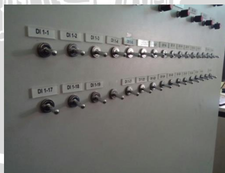
Gambar 3.9 Saklar Input Digital DCS
