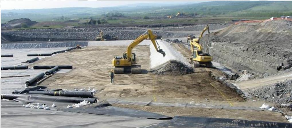
Gambar 4.7 Proses Pemasangan Capping
