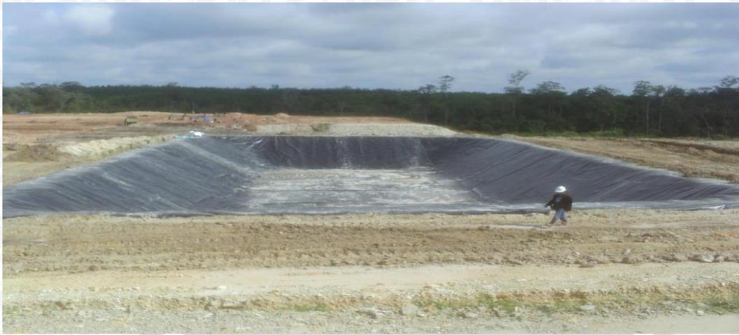
Gambar 4.5 Lapisan Geomembran
