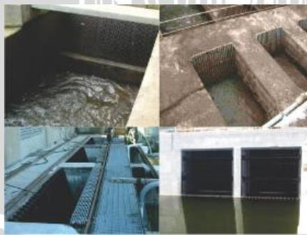
**Gambar 2.17** Bentuk *trash rack*
