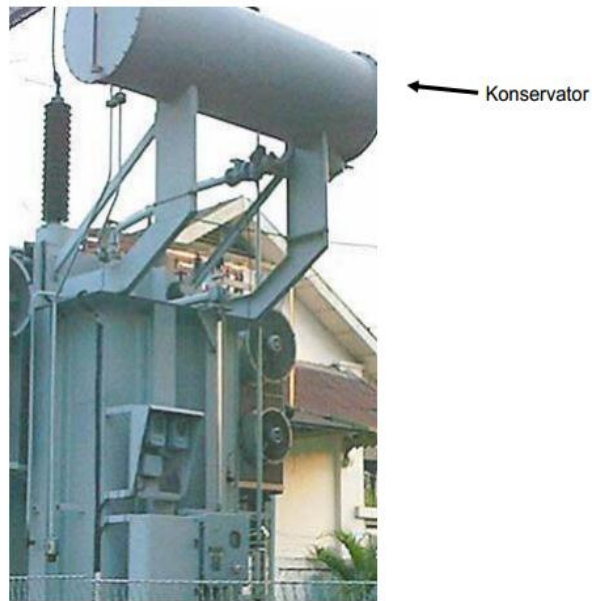
Gambar 2.6 Tangki Konservator Sumber: PT PLN (2003:23)
