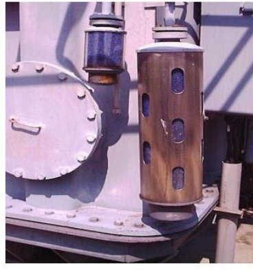
Gambar 2.8 Alat Pernapasan Berupa Tabung Berisi Kristal Zat Hygroskopis Sumber: PT PLN P3B (2003:30)
