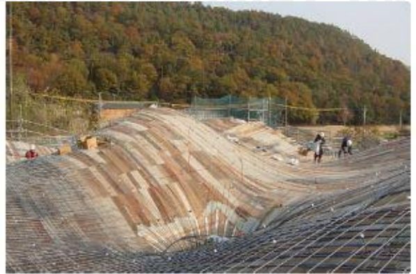
Gambar 2. 29 Bekisting struktur cangkang Sumber: Adriaenssens (2014)
