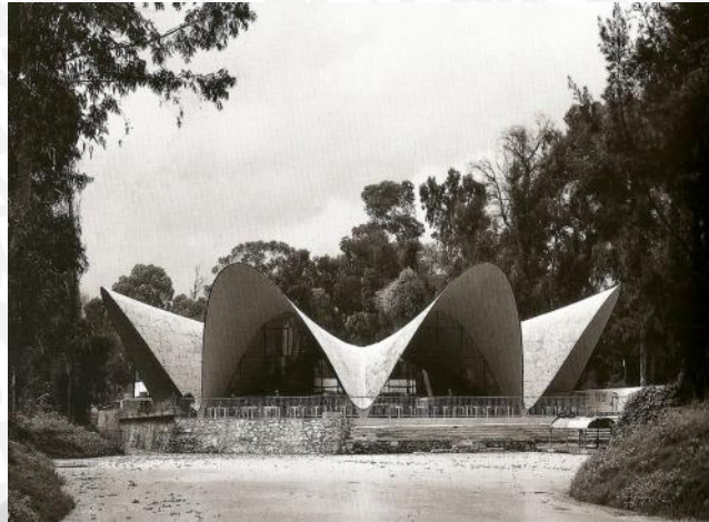
Gambar 2. 16 Penerapan cangkang atap gantung di Xochimilco Sumber: Ramaswamy (1968)
