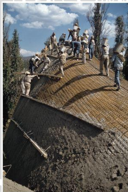
Gambar 2. 30 Cast in place shells dengan teknik manual Sumber: Adriaenssens (2014)
