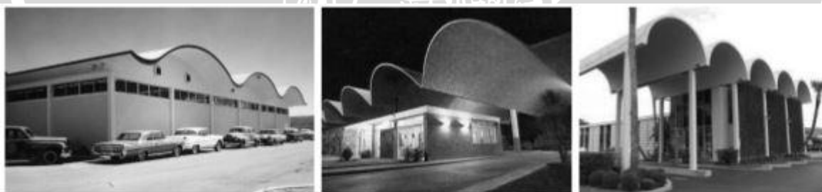
Gambar 2. 14 Struktur cangkang silinder Sumber: Ramaswamy (1968)
