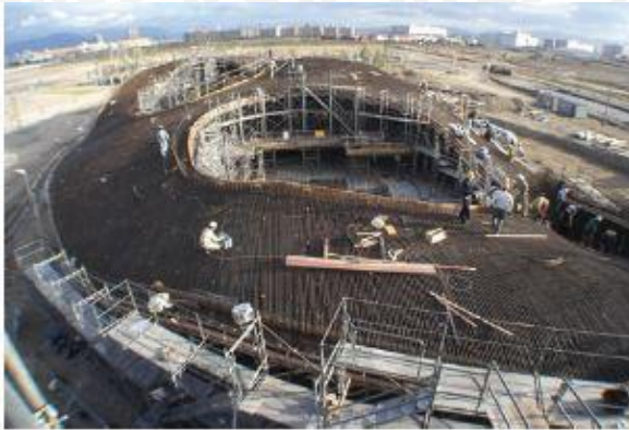
Gambar 2. 29 Bekisting struktur cangkang Sumber: Adriaenssens (2014)
