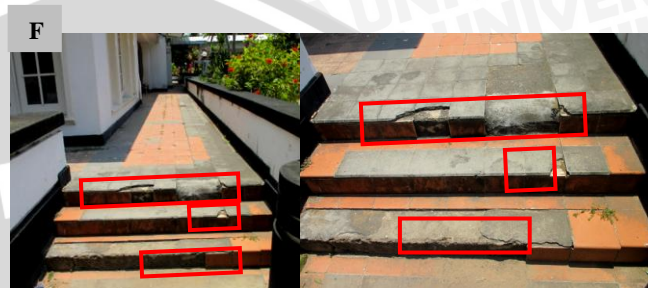
Kerusakan F yang terjadi yaitu pengelupasan lantai di anak tangga koridor sisi bagian timur dari bangunan induk kantor Bakorwil
