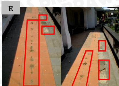
Kerusakan E yang terjadi yaitu pengelupasan lantai dan pada nat lantai tumbuh tanaman liar
