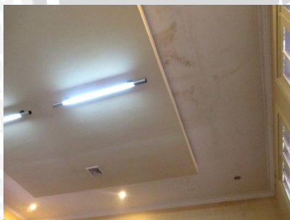
Plafon ruang kepala badan Bakorwil
