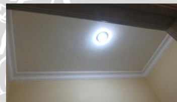
Plafon toilet kepala badan Bakorwil Jenis plafon 5 tidak mempunyai ornamen/motif dan lubang angin pada plafon
