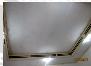
Plafon ruang pembangunan ekonomi
