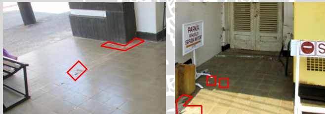
Gambar 4.391 Kerusakan C dan D motif lantai 1 bangunan penunjang Kantor Bakorwil IV Jatim Pamekasan
