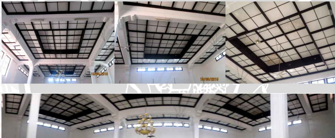
Gambar 4.347 Jenis tipe plafon 1 pada ruang aula pertemuan bangunan induk Kantor Bakorwil IV Jatim Pamekasan
