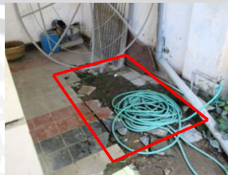
Gambar 4.392 Kerusakan E motif lantai 2 bangunan penunjang Kantor Bakorwil IV Jatim Pamekasan
