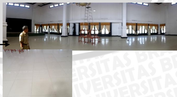
Motif lantai jenis 1 merupakan lantai keramik berwarna krem berukuran 60cmx60cm. Merupakan material lantai baru pada bangunan induk kantor Bakorwil Gambar 4.373 Motif lantai 1 pada bangunan induk Kantor Bakorwil IV Jatim Pamekasan Sumber: Kantor Bakorwil IV Jatim Pamekasan
