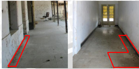
Gambar 4.390 Kerusakan A dan B motif lantai 1 bangunan penunjang Kantor Bakorwil IV Jatim Pamekasan
