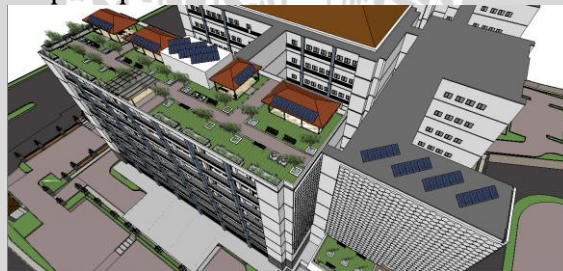
Gambar 6. Rangkaian photovoltaic panel pada atap gedung C
