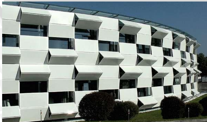
Gambar 2.5 Aplikasi Fasad Kinetik dengan Metode Translation
