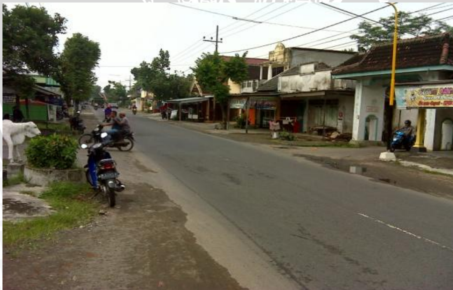
Gambar 1.1 Salah Satu Ruas Jalan yang Belum Memiliki Saluran Drainase
