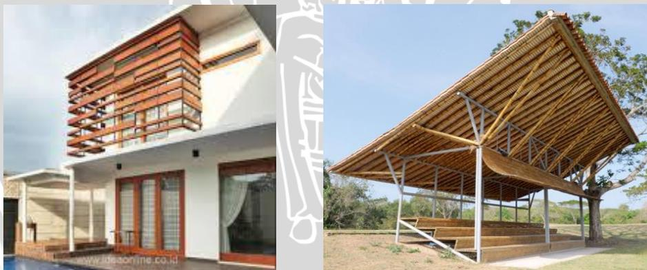
Gambar 4.29 *Shading device* dengan material alami
