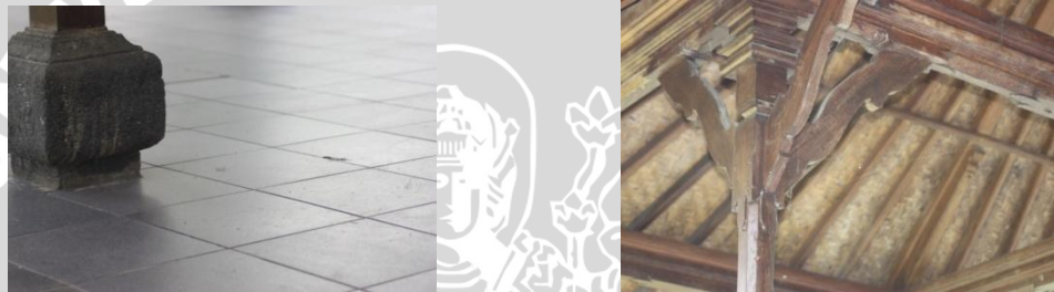
Gambar 4.64: Detail pada umpak dan sangawang di Bale Gong.
