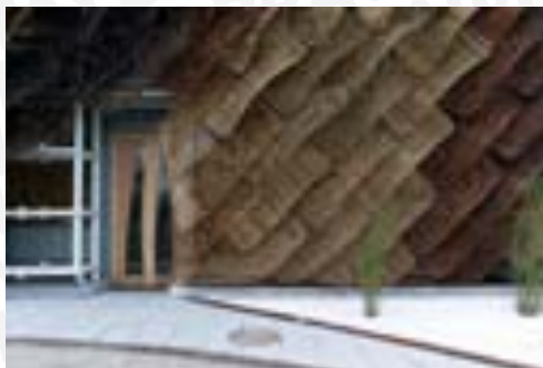
Gambar 4.34 Penggunaan rotan pada selubung bangunan
