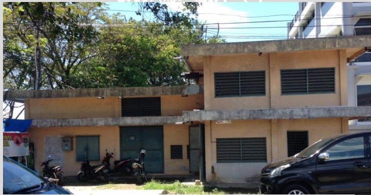
Gambar 4.9 Bangunan Untuk Gudang dan Genset.
