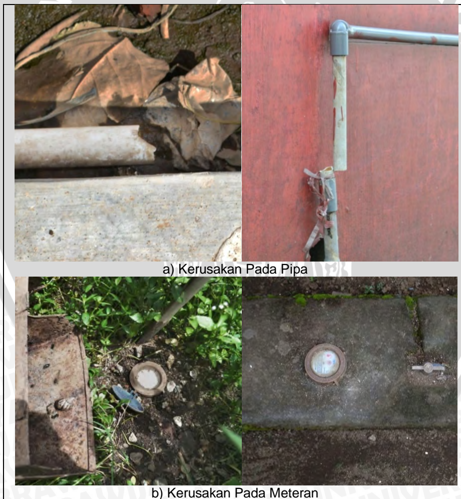
Gambar 4.18 Penyebab Kehilangan Air pada HIPPAM di Desa Genengan
