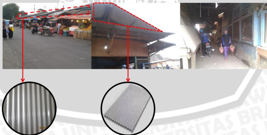
Gambar 4.12 Kondisi atap eksisting Pasar Induk Gadang (sumber: Dokumen Pribadi)
