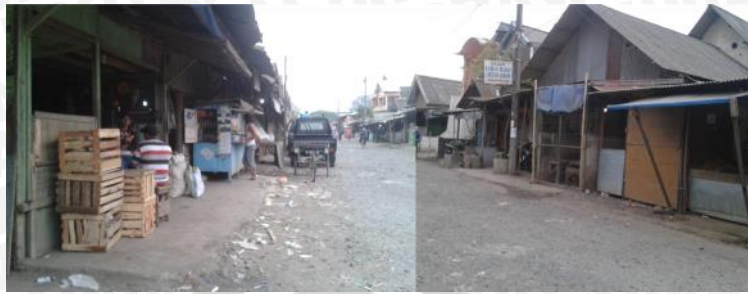
Gambar 4.11 Kondisi dinding eksisting Pasar Induk Gadang (sumber: Dokumen Pribadi)
