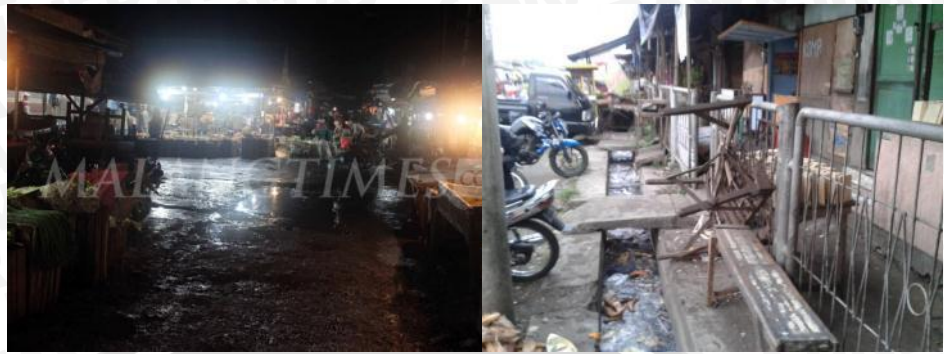
Gambar 4.15 Kondisi sistem drainase
