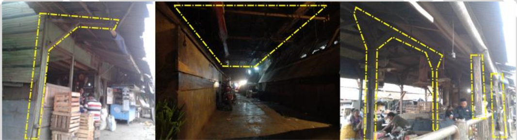
Gambar 4.13 Kondisi sistem struktur (sumber: Dokumen Pribadi)
