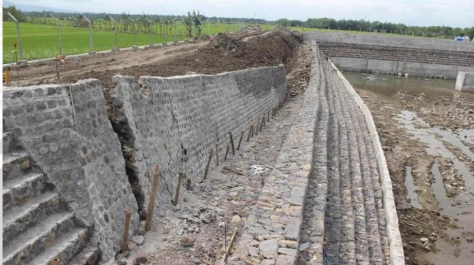
Gambar 3.4 Kondisi dinding penahan *existing* di lapangan
