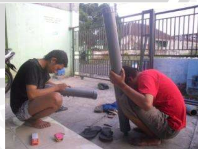
Gambar 3.11. Perakitan Pompa (sumber : dokumentasi)
