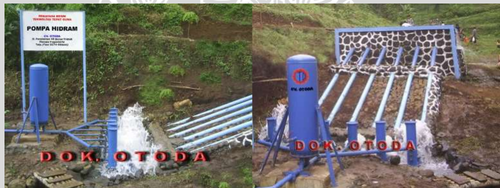
Gambar 2.12. Contoh Pemasangan Pipa Inlet Pada Pompa Hidram di Sleman (sumber : www.google.com/pompa hidram diunduh November 2014)
