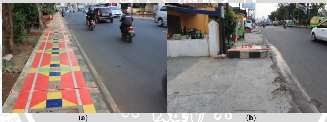
Gambar 4.19 Kondisi Jalur Pejalan Kaki di Segmen 1 (a) Zona A dan (b) Zona B Jalan Jendral Sudirman
