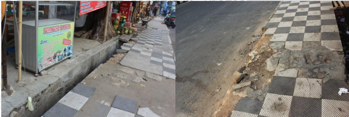
Gambar 4.23 Kondisi Perkerasan Jalur Pejalan Kaki di Segmen 2
