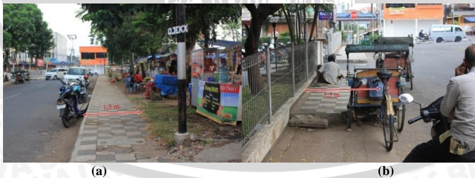
Gambar 4.25 Kondisi Jalur Pejalan Kaki di Segmen3(a) Zona A (b) Zona B Jalan Jendral Majapahit
