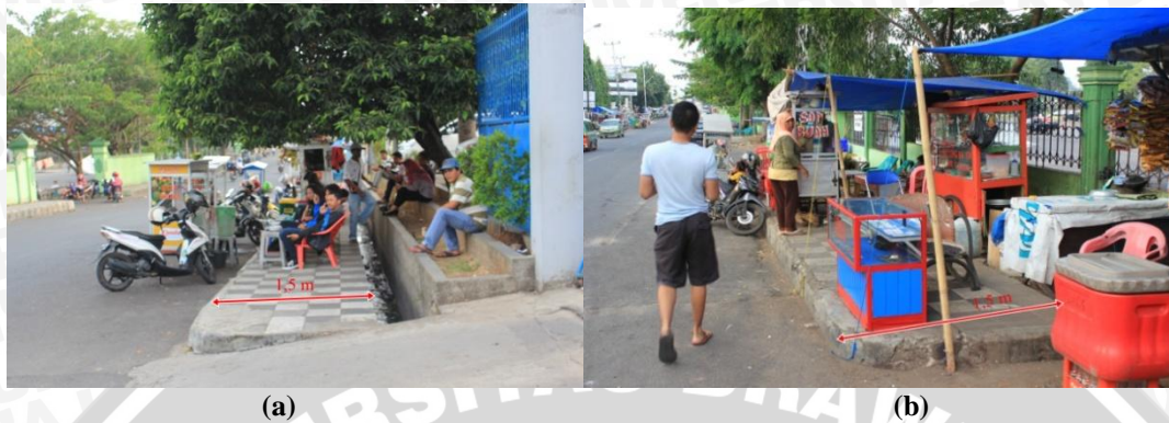
Gambar 4.28 Kondisi Jalur Pejalan Kaki di Segmen 4 (a) Zona A (b) Zona B Jalan Sriwijaya
