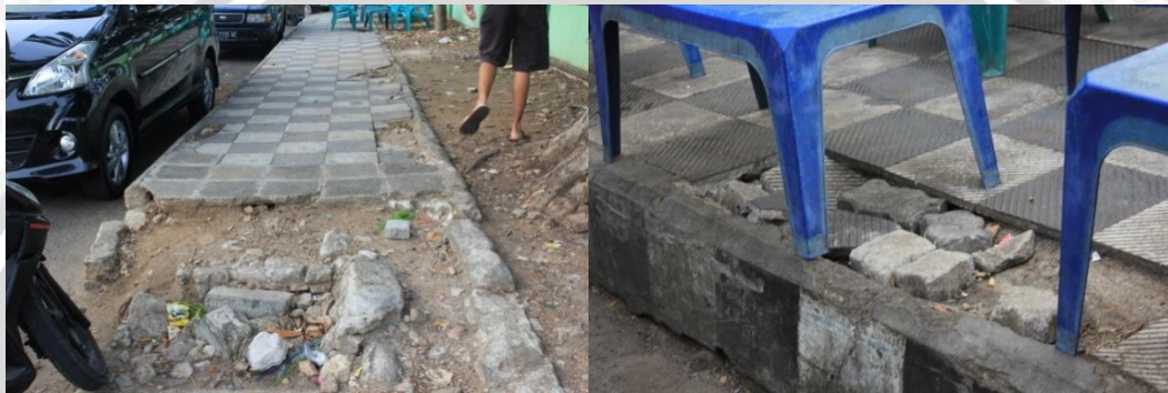
Gambar 4.32 Kondisi Perkerasan Jalur Pejalan Kaki di Segmen 5
