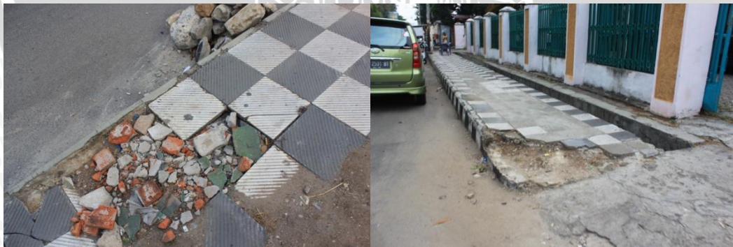
Gambar 4.29 Kondisi Perkerasan Jalur Pejalan Kaki di Segmen 4
