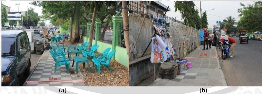
Gambar 4.31 Kondisi Jalur Pejalan Kaki di Segmen 5 (a) Zona A (b) Zona B Jalan Majapahit
