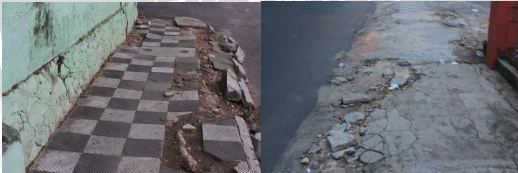
Gambar 4.35 Kondisi Perkerasan Jalur Pejalan Kaki di Segmen 6
