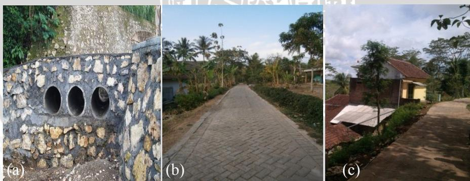
**Gambar 4.5** Proyek pembangunan infrastruktur jalan PNPM MPd Kecamatan Pagak; (a) TPT di Desa Gampingan Dusun Dempok; (b) Con Block di Desa Pagak Dusun Banyuurip; (c) Rabat Jalan di Desa Sumbermanjing Kulon Dusun Krajan;
