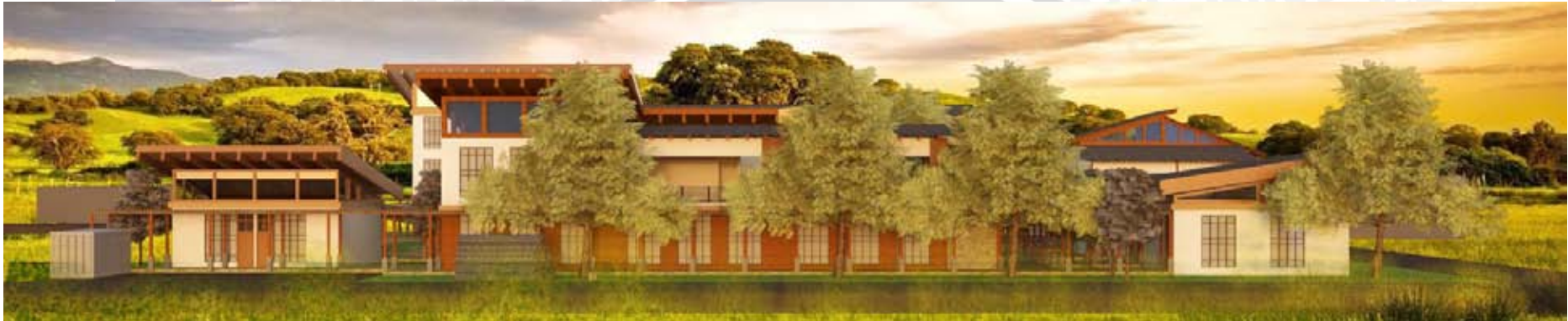
15. Tampak Barat bangunan Pusat Pelatihan Seni Ukir
