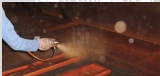
Gambar 2.3 Finishing dengan teknik spray
