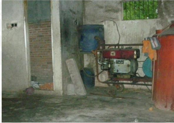
Gambar 4.5. Instalasi pompa limbah cair dan generator listrik
