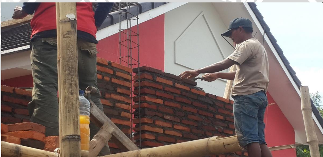
Pemasangan Dinding Bata Konvensional
