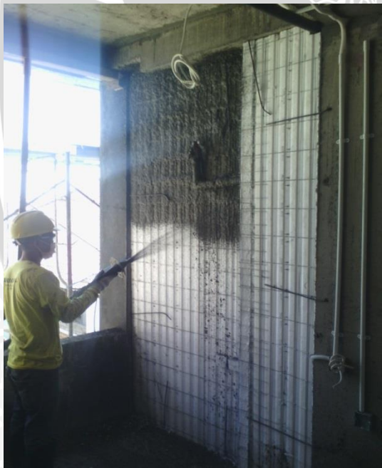
Proses penyemprotan plester ke dinding panel.
