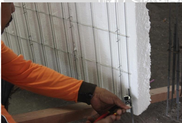
Mengikat dinding panel dengan besi stek.
