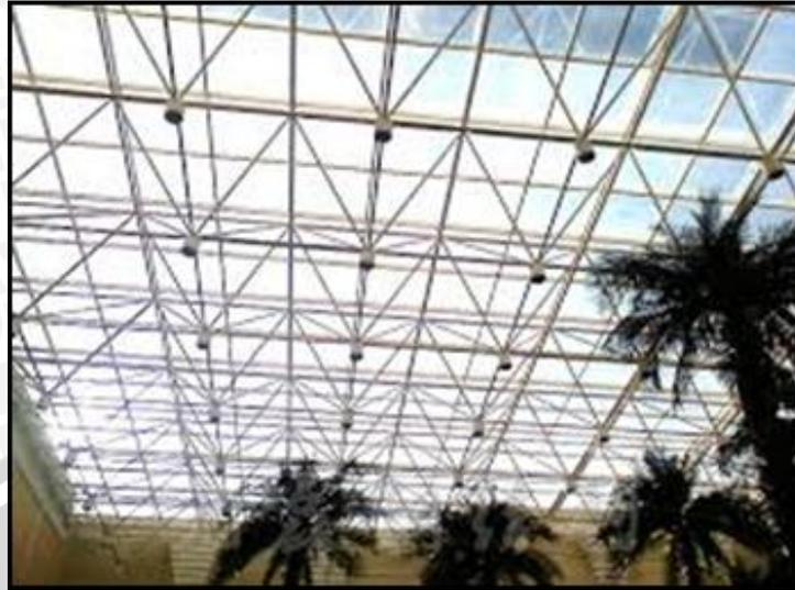
Gambar 2.19 Struktur rangka ruang
