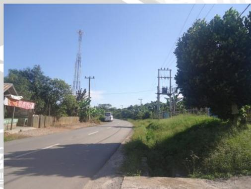
**Gambar 4. 25 Ruas Jalan yang Tidak dilengkapi Drainase**
