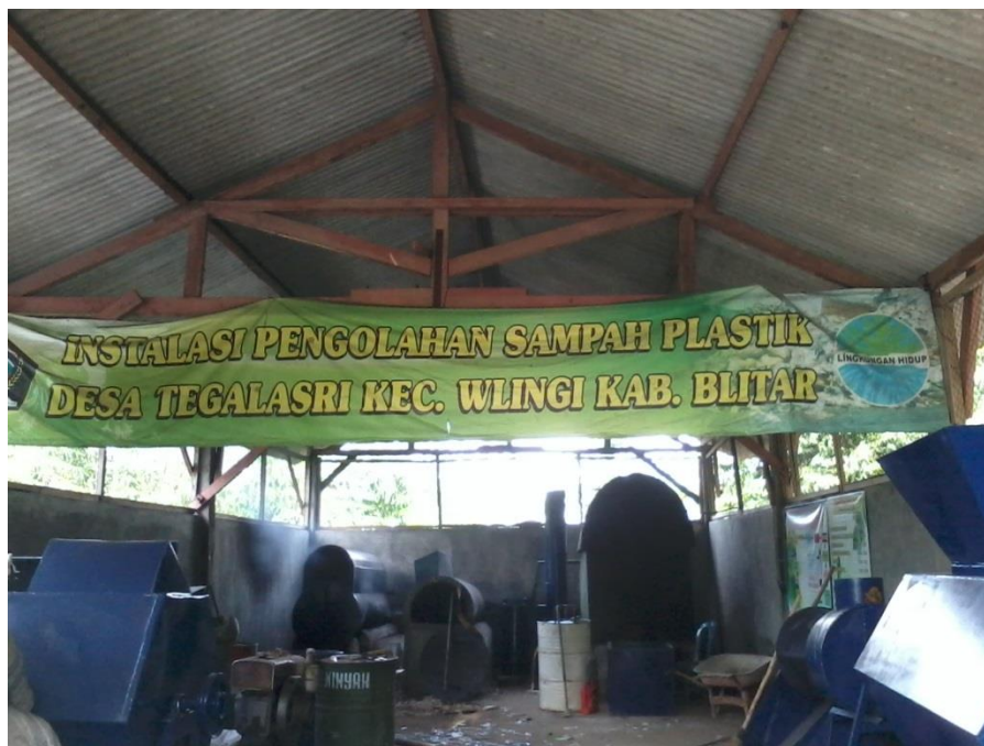
Gambar 4.5 Instalasi Pengolahan Sampah Plastik TPA Tegal Asri
