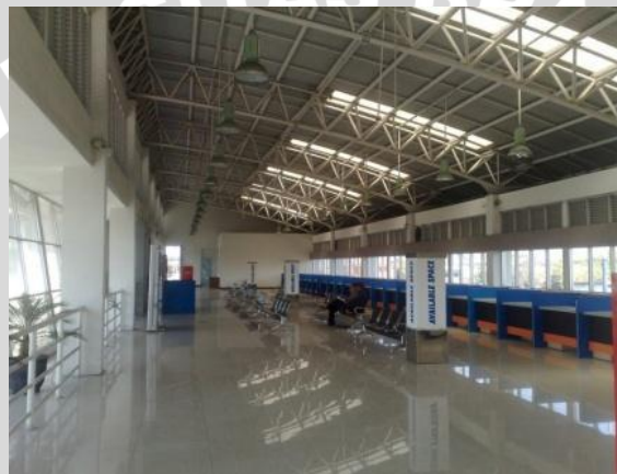
Gambar 2. 47 Struktur pada Terminal Purbaya
