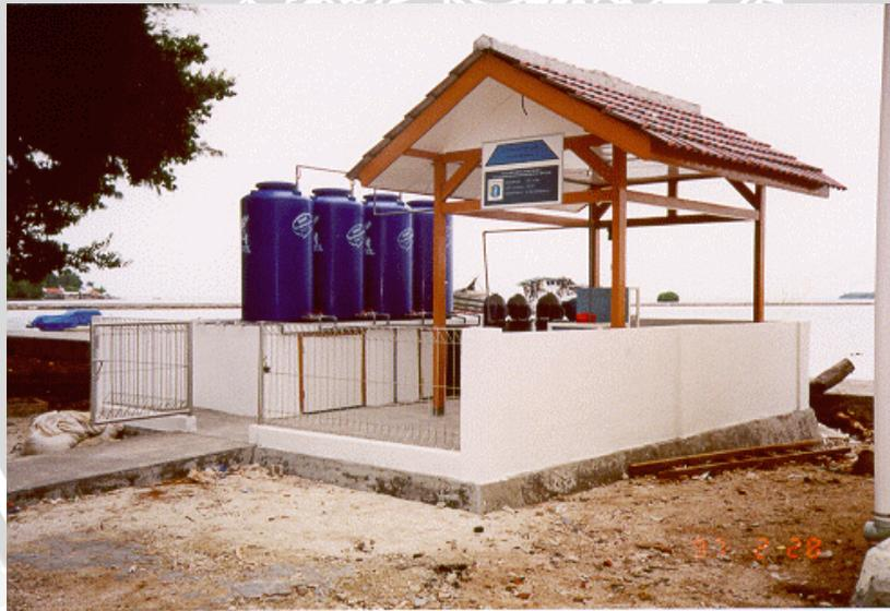
Gambar 4.32 sistem instalasi IPA RO
