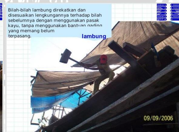
Gambar 2.13 Pemasangan bilah lambung
