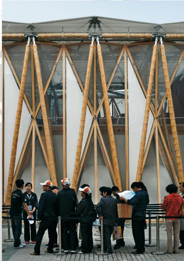
Gambar 2.44 Selubung membran pada fasad bangunan
