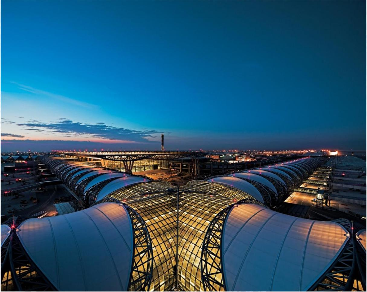
Gambar 2.26 Bangkok Suvarnabhumi airport dengan selubung atap membran PVC
