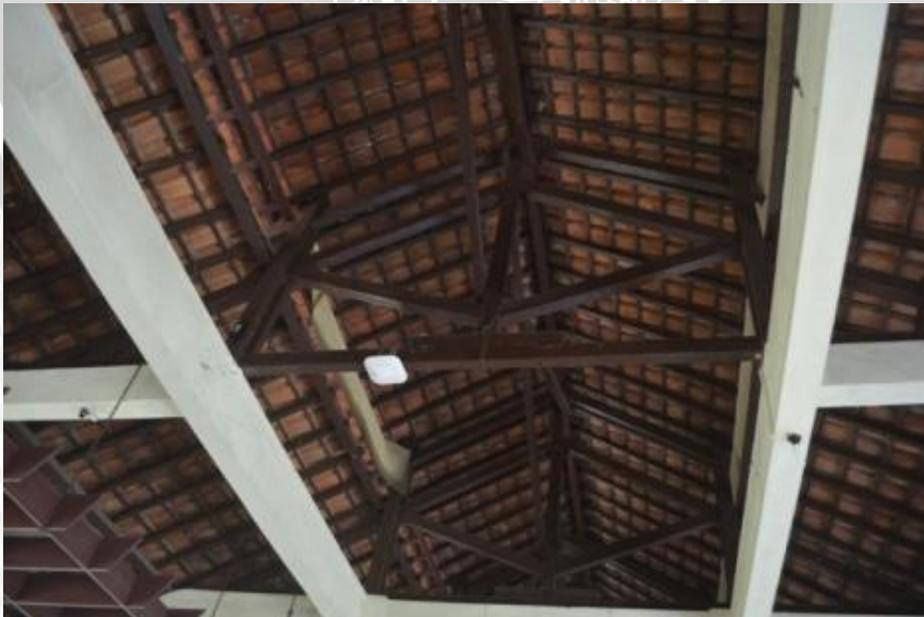
Gambar 2.32 Ekspose Struktur Atap dengan konstruksi Kayu
