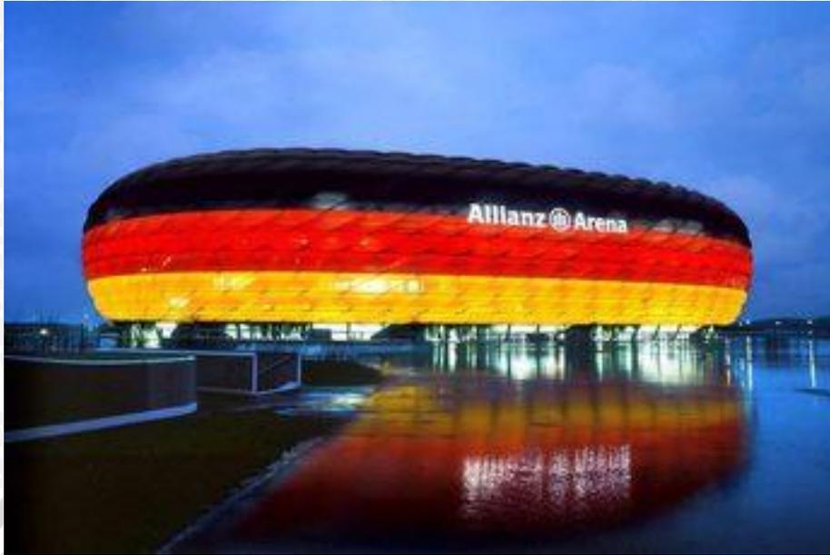
Gambar 2.28 Allianz Arena menggunakan Struktur membran ETFE
