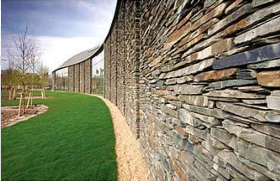
Gambar 2.40 *Fasade* bangunan menggunakan material lokal batu alam.
