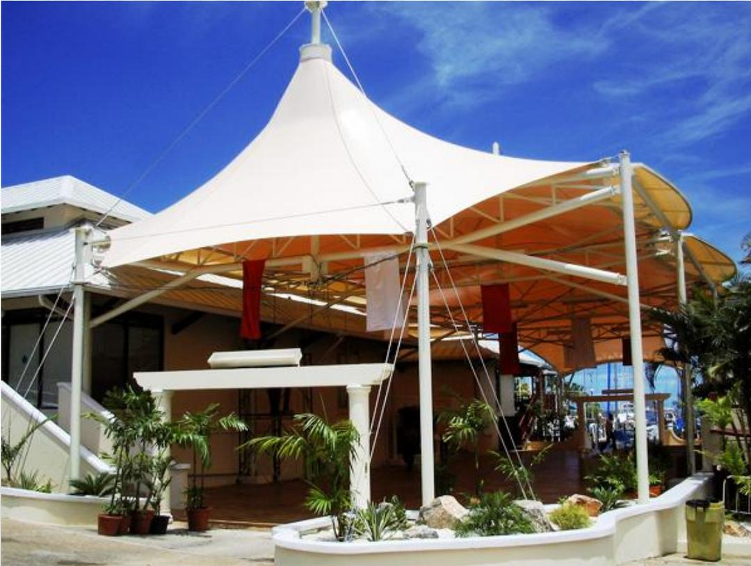
Gambar 2.27 Struktur atap membran PTFE
