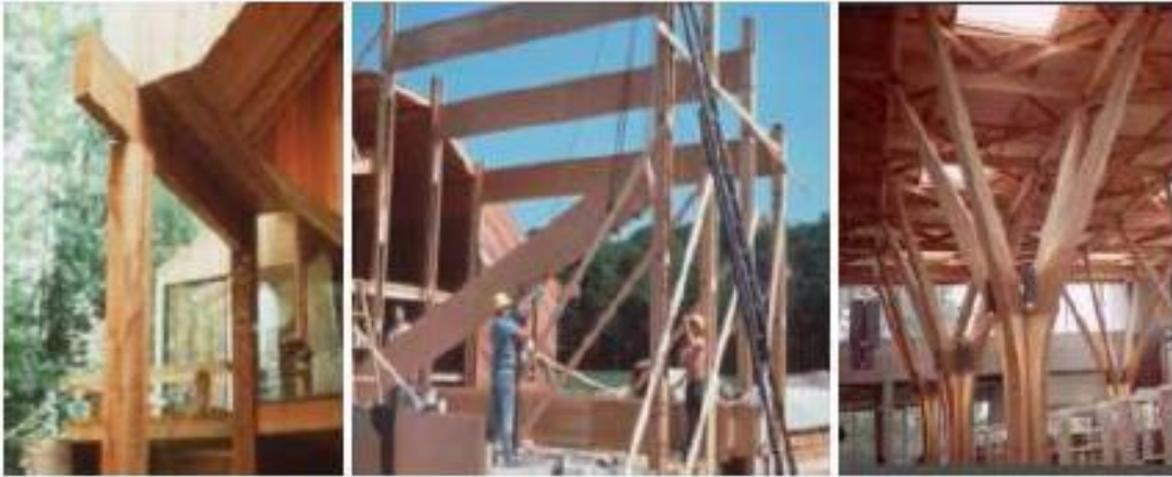
Gambar 2.23 Kolom tunggal, kolom ganda dan produk kolom laminasi
