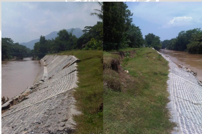
Gambar 3.3 Kondisi dinding penahan eksisting melalui peninjauan lapangan
