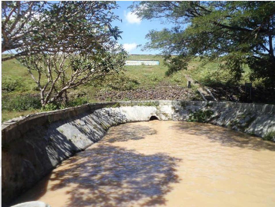
Gambar 3. 3 Kondisi Intake Di Waduk Dawuhan
