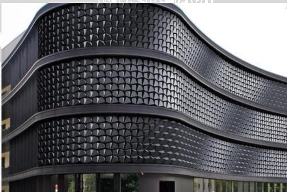
Gambar 2.23 Aplikasi fasade kinetik dengan metode rotation
