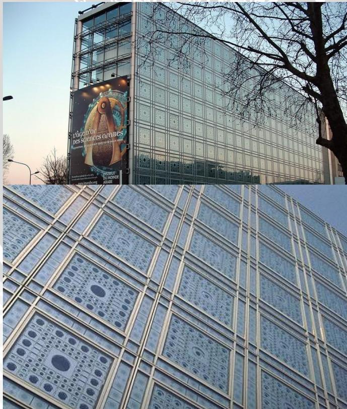
Gambar 2.21 Aplikasi fasade kinetik dengan metode *scaling*
