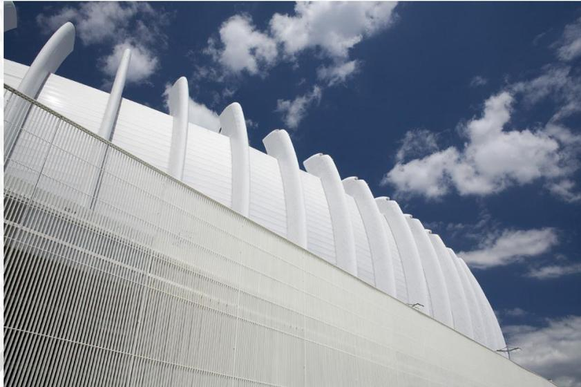
Gambar 2.52 Kombinasi material beton dan polikarbonat pada fasade bangunan
