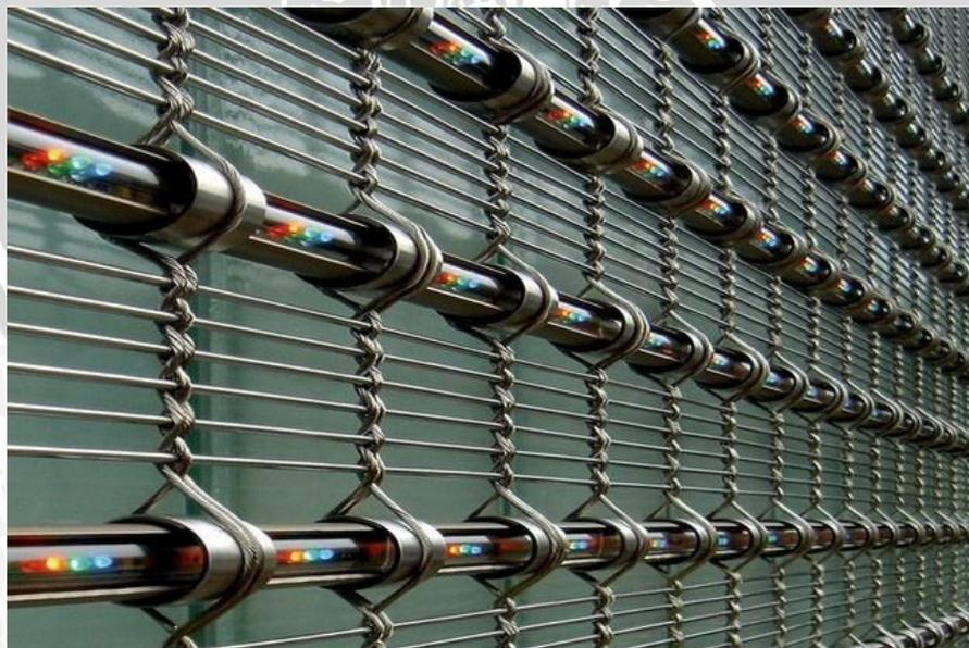
Gambar 2.34 Detil pemasangan teknologi LED pada fasade bangunan
