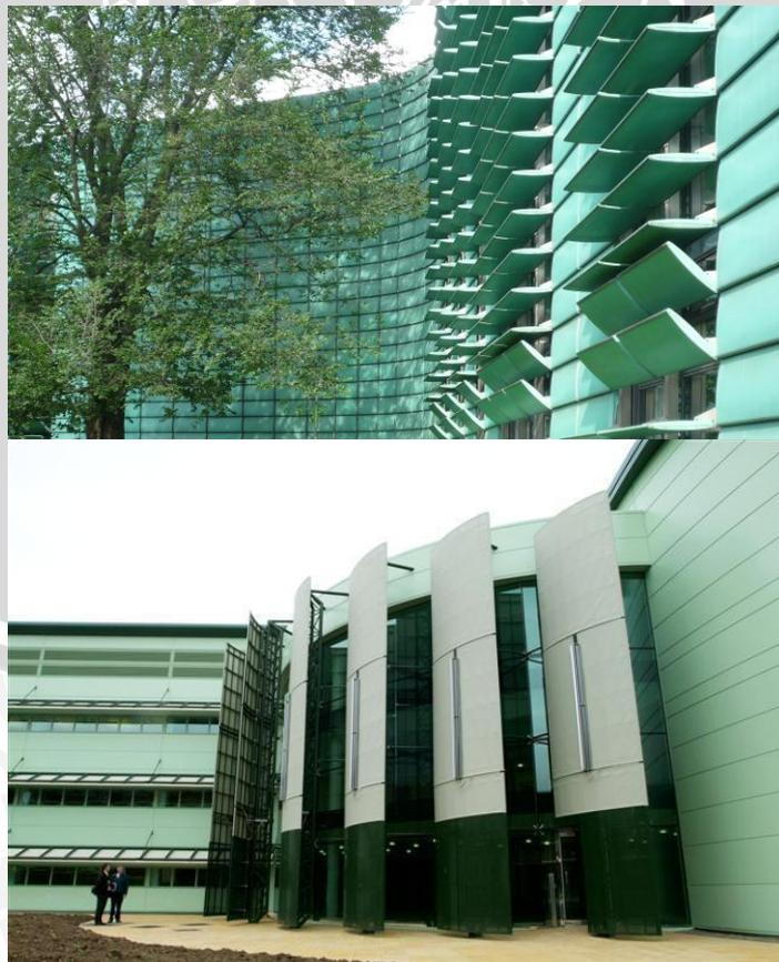
Gambar 2.17 Aplikasi fasade kinetik dengan metode *rotation*
