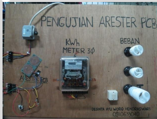
Foto simulasi pengujian arester PCB sebelum pengujian dengan menggunakan tegangan tinggi impuls
