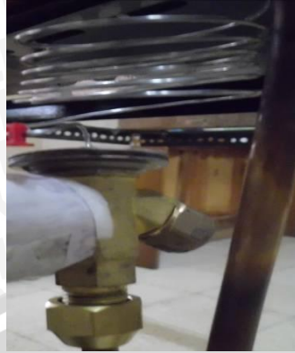
Gambar 3.3. Katup ekspansi
