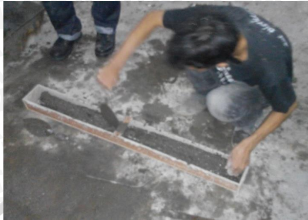
Gambar Pencetakan Beton Ke Dalam Bekisting
