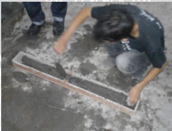
Pencetakan Beton Ke Dalam Bekisting
