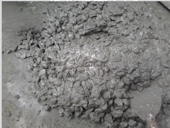
Gambar L-2.2 Proses pembuatan beton
