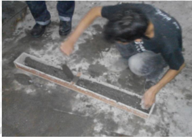
Gambar Pencetakan Beton Ke Dalam Bekisting
