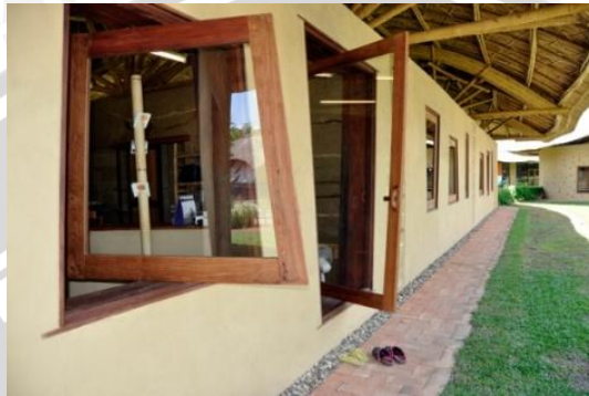
Gambar 2.63 Dinding dari tanah liat di paviliun ruang kelas dan penggunaan botol-botol dan pintu mesin cuci sebagai sumber pencahayaan alami.
