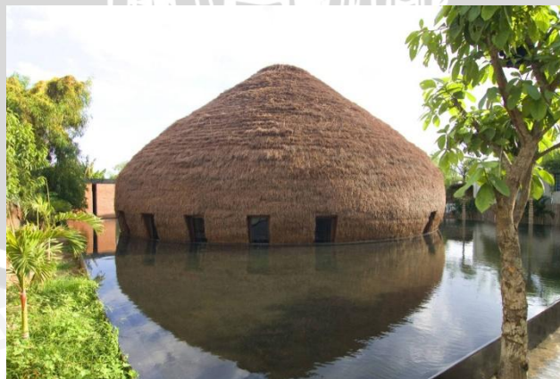
Gambar 2.74 Penutup atap dari rumbia
