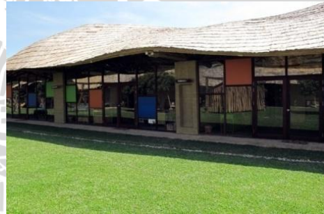
Gambar 2.53 (a) jenis struktur atap yang langsung bertumpu pada batu umpak; (b) Jenis struktur atap yang bertumpu pada dinding yang kemudian di teruskan pada pondasi
