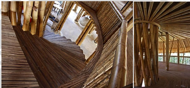
Gambar 2.67 penggunaan bambu tangga, lantai dan struktur atap.
