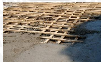
Sumber: Akmal (2011) Gambar 2.27 Lantai pelat bambu
