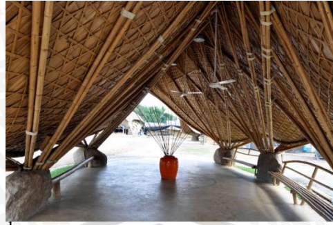
Gambar 2.52 penggunaan bambu seluruhnya dan dengan ikatan tradisional.
