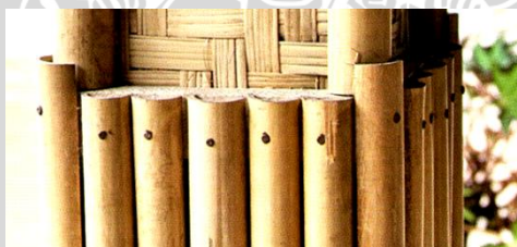
Gambar 2. 45 Sambungan dengan baut
