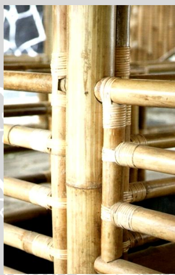
Gambar 2.48 Ikatan pada Restoran Ponyo
