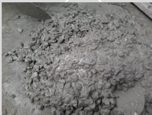
Gambar L-2-2 Pencampuran semen, pasir, dan kerikil
