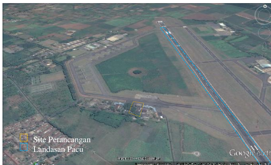
Gambar 4.20 Kondisi Fisik Site
