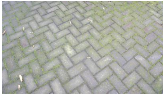
Gambar 4.18 Kondisi Penutup Tanah pada Tapak
