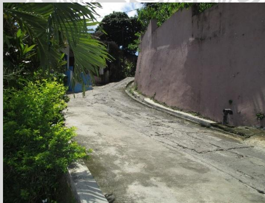
Gambar 4.30 Akses jalan jembatan Betek sisi Utara
