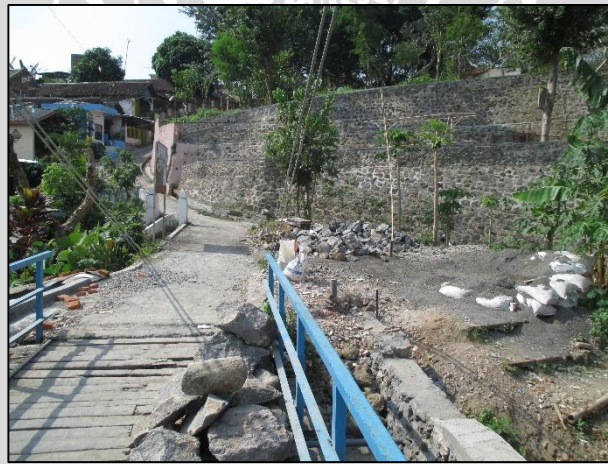
Gambar 4.32 Timbunan pasir dan batu diletakkan pada sisi utara jembatan
