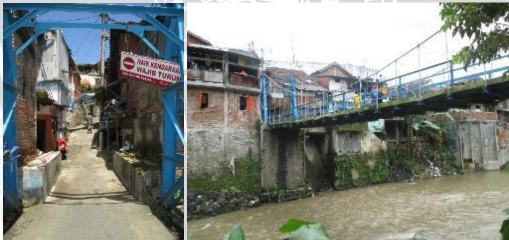
Gambar 4.28 sisi Selatan Jembatan Betek
