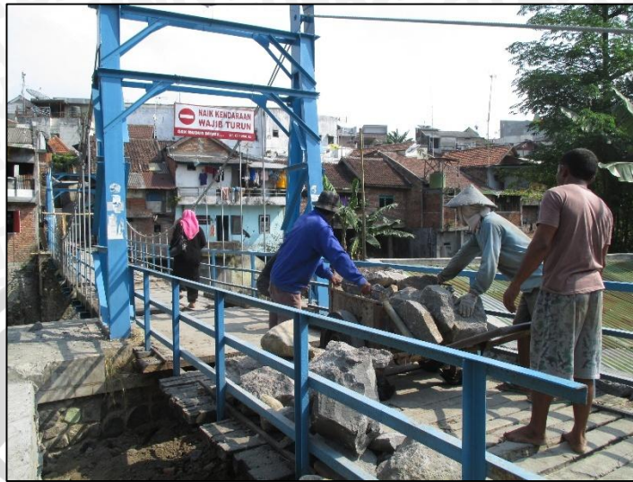
Gambar 4.33 Pemindahan material dengan menggunakan gerobak
