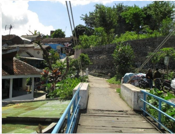
Gambar 4.29 Sisi Utara Jembatan Betek
